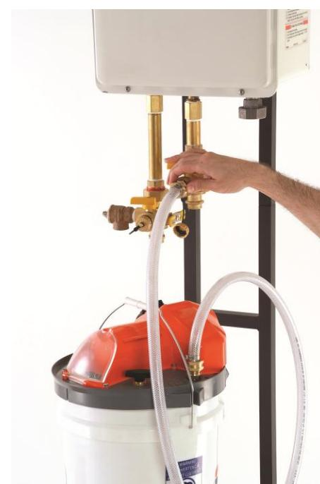
Verbinden Sie den Rücklaufschlauch mit einem Zugangsventil.
