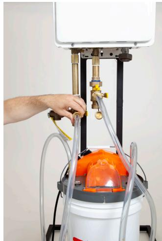
Conecte la manguera de retorno a una válvula de acceso.
