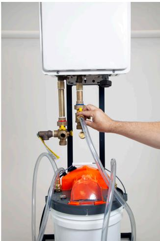
Conecte la manguera de salida a una válvula de acceso.
