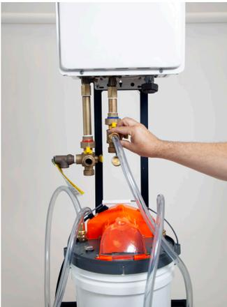
Verbinden Sie den Ablaufschlauch mit einem Zugangsventil.
