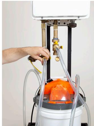
Verbinden Sie den Rücklaufschlauch mit einem Zugangsventil.
